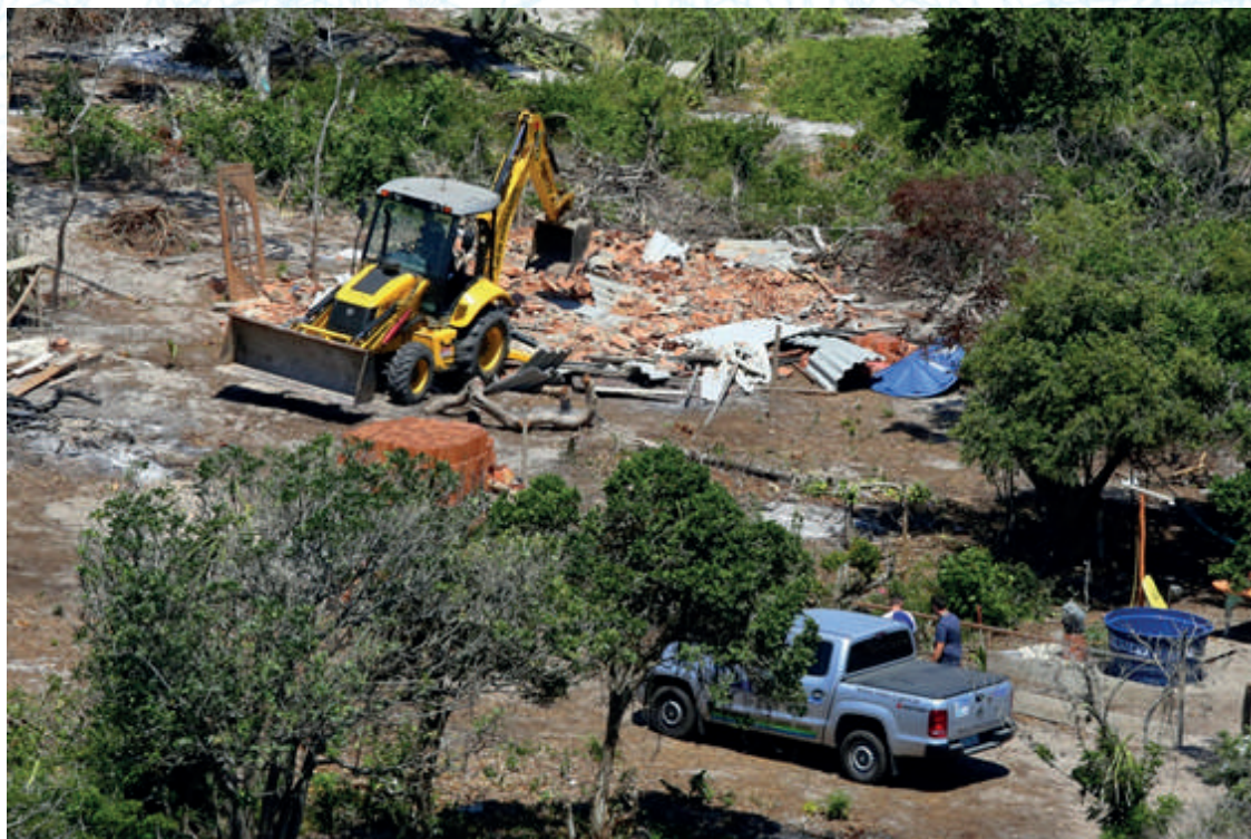
Operação do Inea demolindo ocupação irregular.
